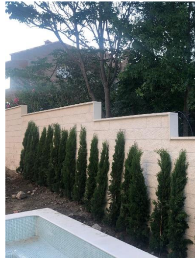
Muro de bloque de hormigón blanco de 1m de alto: 125 € / metro lineal
